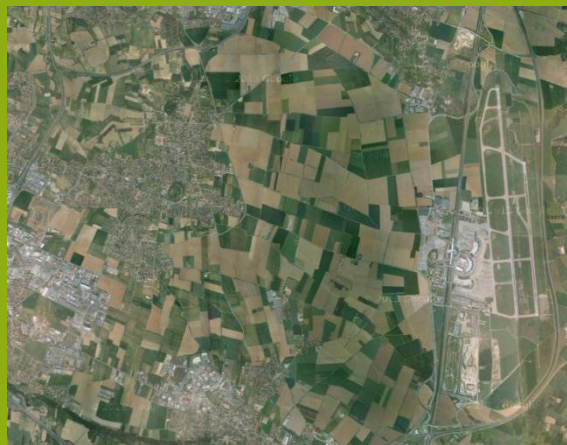
Vue aérienne de l'Est Lyonnais avec à droite l'aéroport St Exupéry (source Google Maps)
